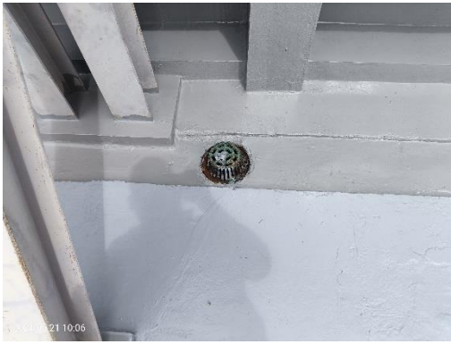
ท่อรับน้ำฝนจากบนอาคาร
