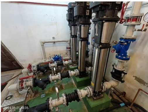
ปั๊มสูบน้ำใช้ขึ้นถังเก็บน้ำดาดฟ้า
