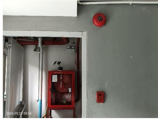
Manual Station และ Alarm bell
