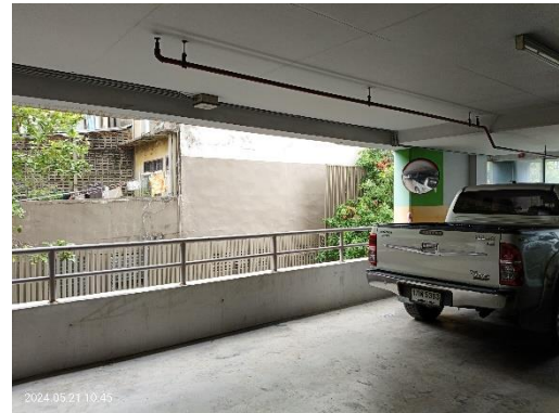
ช่องเปิดระบายอากาศทางธรรมชาติบริเวณอาคารจอดรถ และ ภายในอาคาร
